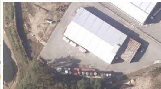
Vista de las instalaciones vía satélite
